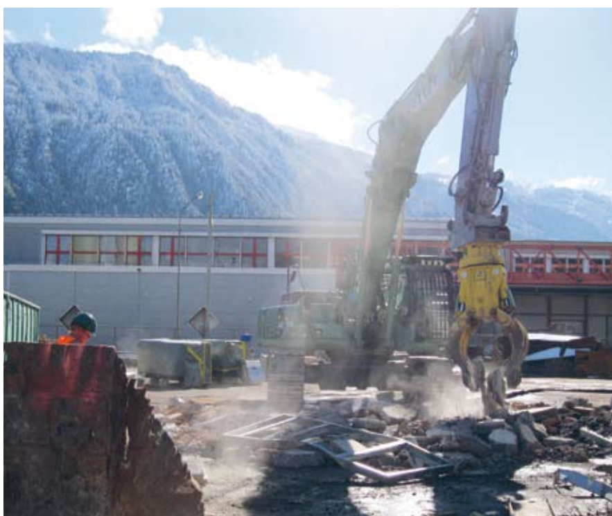
Im Herbst 2013 erfolgte der Rückbau des Gasometers.
