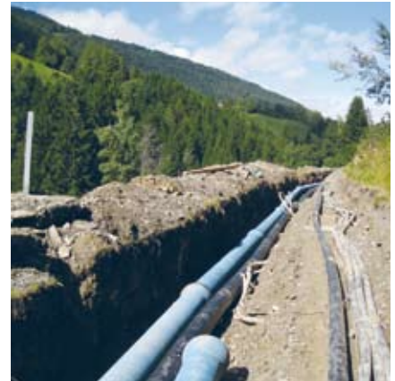
Leitungsbau entlang Polenweg
