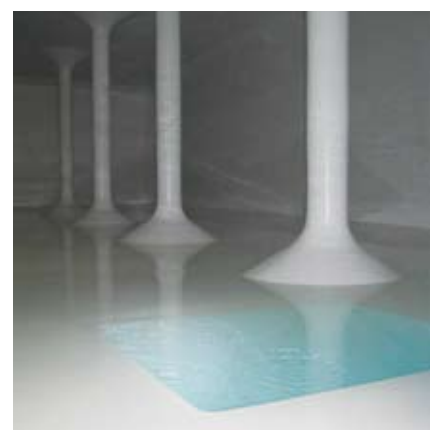
Eine der neu beschichteten Trinkwasserkammern
