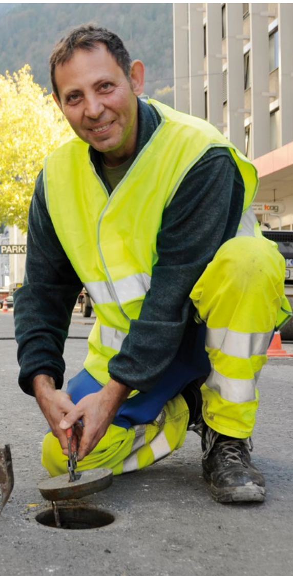
Urs Torri (links) und Sergio Paniga bei der Kontrolle der Abschlussarbeiten.
