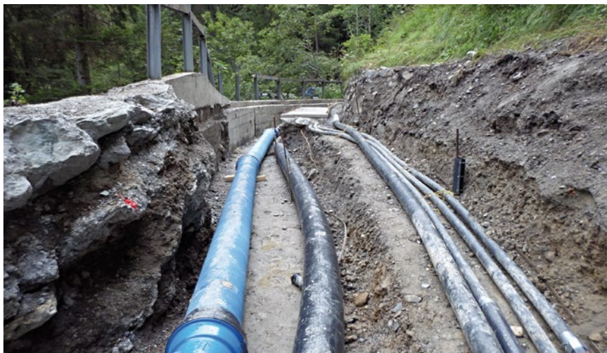
Die verlegten Wassertransportleitungen im Polenweg.
