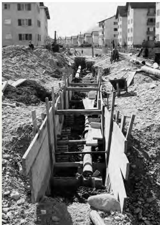
Werkleitungen Ringstrasse um 1950
