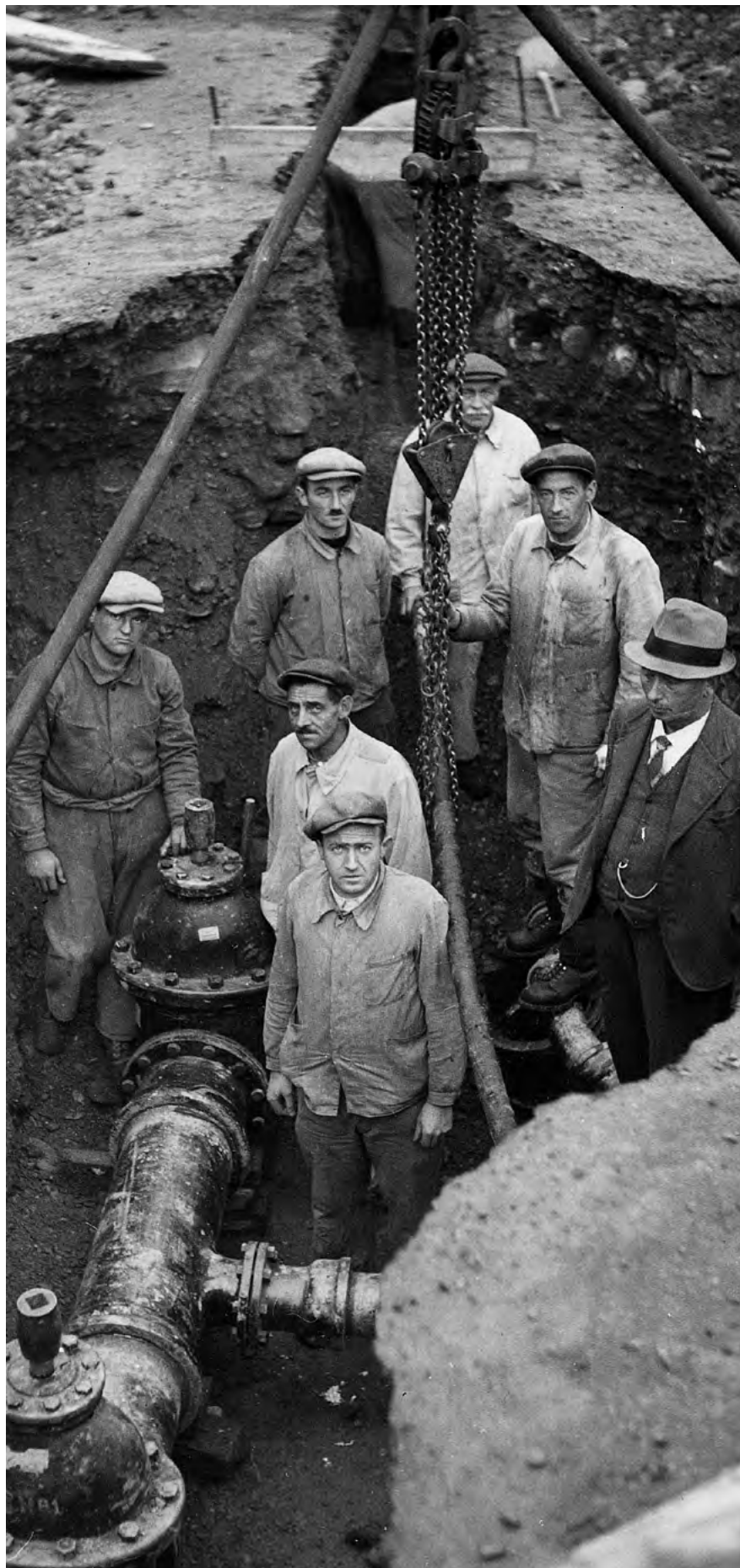
Leitungsbau zum Pumpwerk Rheinstrasse 1940
