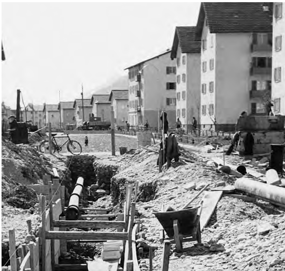
Montage neue Druckwasserleitung Churwalden–Chur im Gebiet Erlenrutsch
