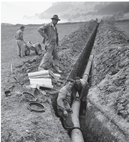
1955: Leitungsbau in Parpan
