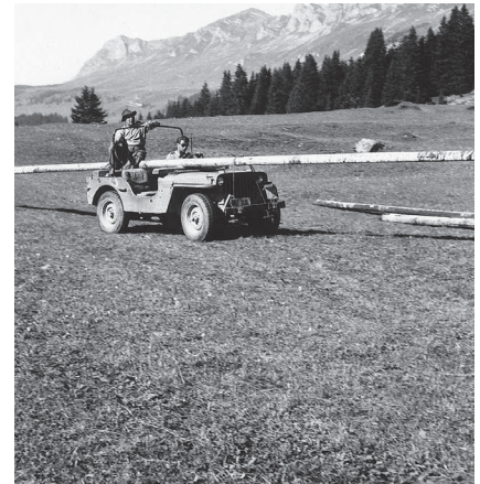
1952: Rohrtransport auf Plam Nesa (Valbella)
