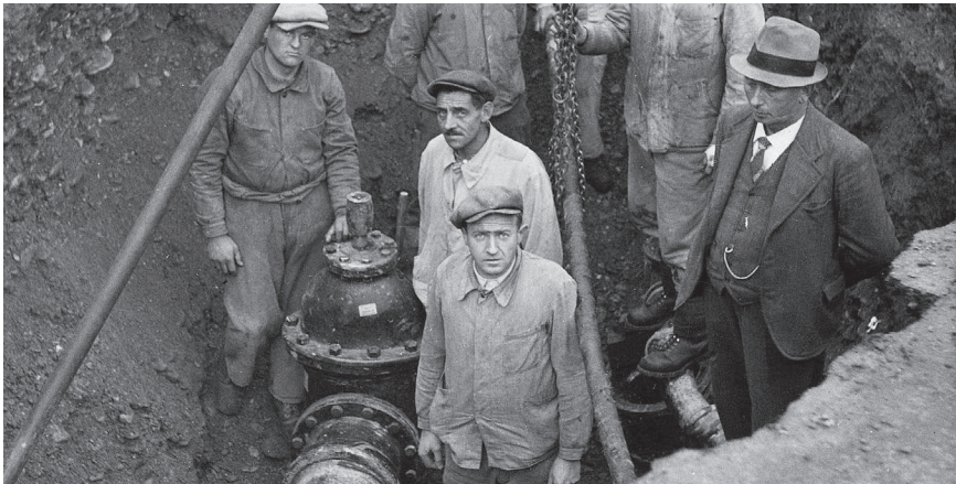
1940: Bau der Leitung zum Pumpwerk Rheinstrasse
