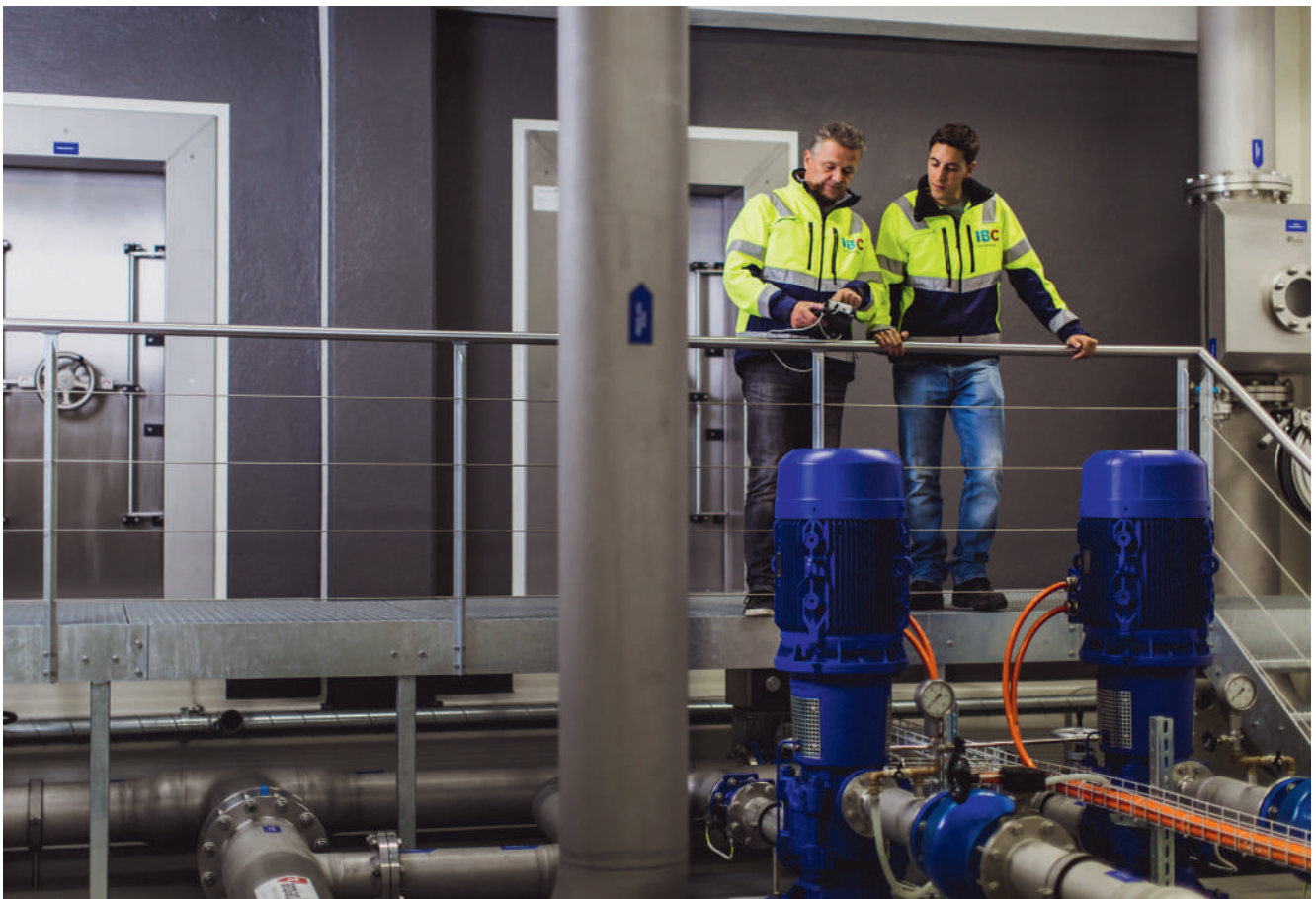
Überprüfung Trinkwasserqualität im Reservoir Waisenhaus
