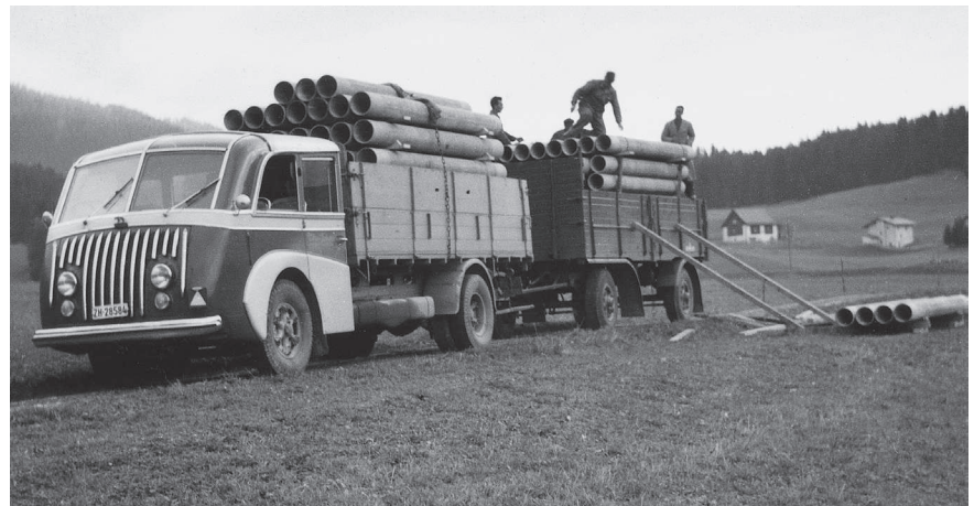
1955: Zehn Tonnen Rohre für eine Baustelle in Parpan
