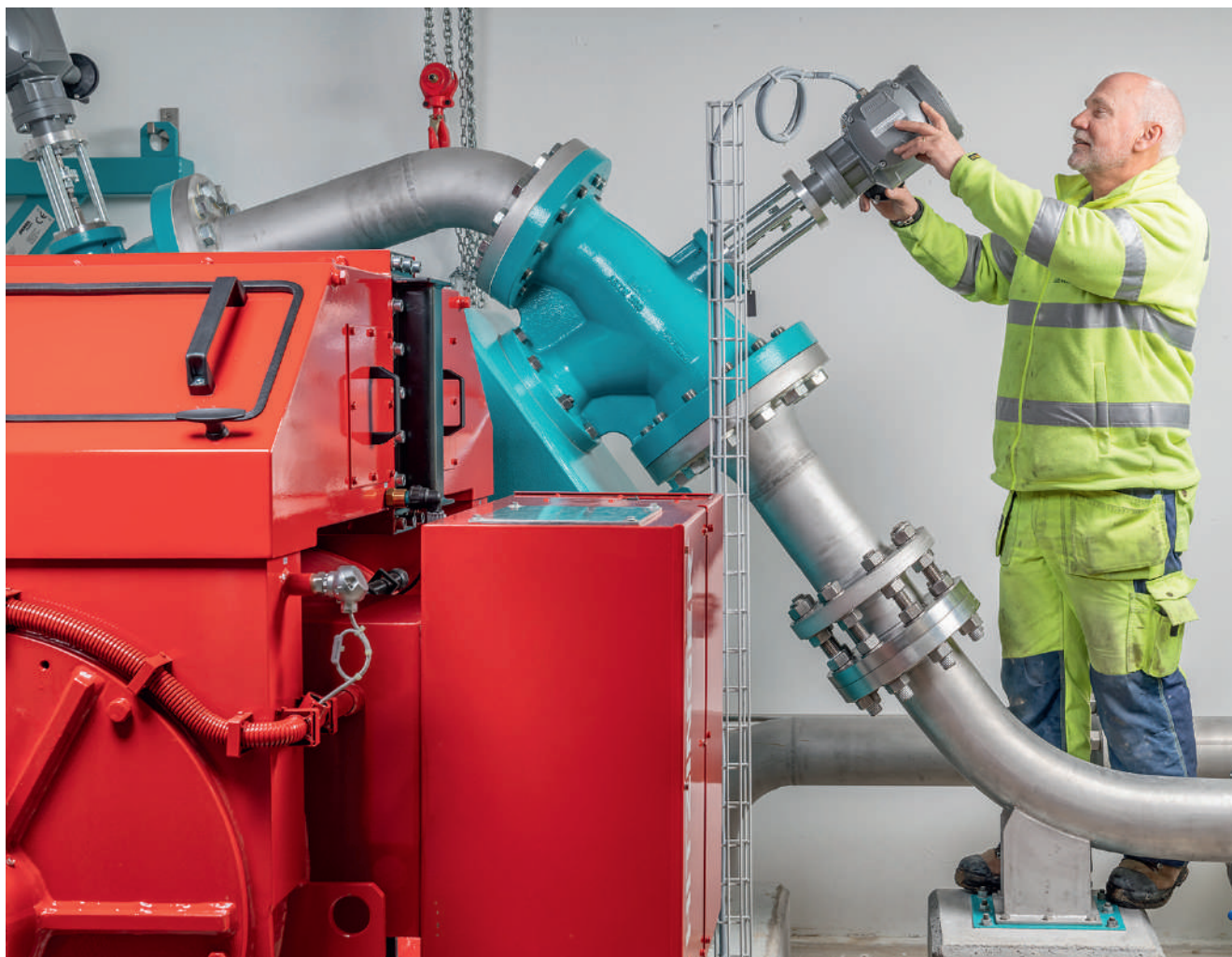
Kontrolle der Trinkwasserturbine im Reservoir Grida
