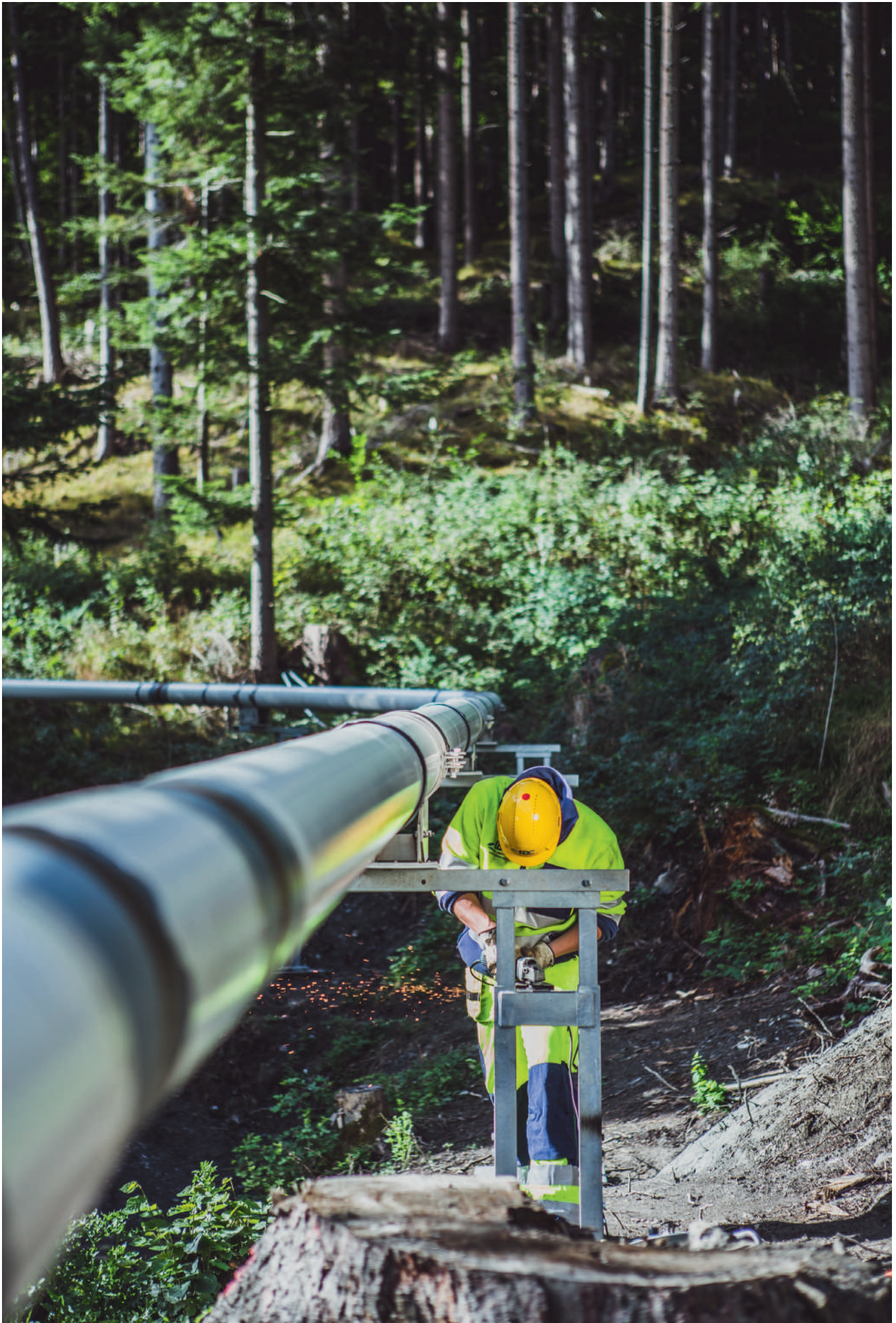
Arbeiten an der Trinkwasserleitung zwischen Parpan und Chur
