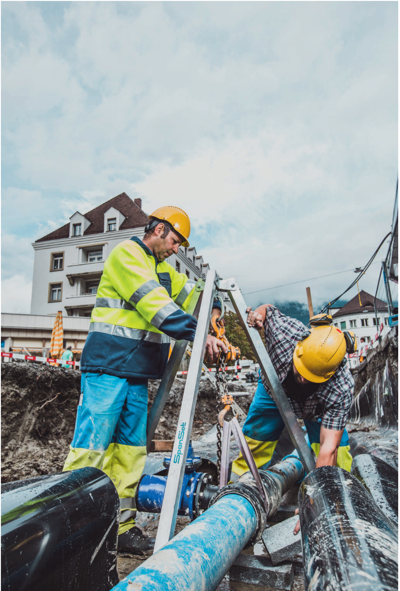
Erneuerungsarbeiten an der Trinkwasserleitung, obere Bahnhofstrasse
