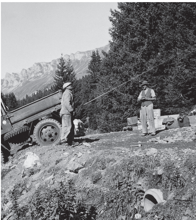
1954: Materialtransport mit Seilzug
