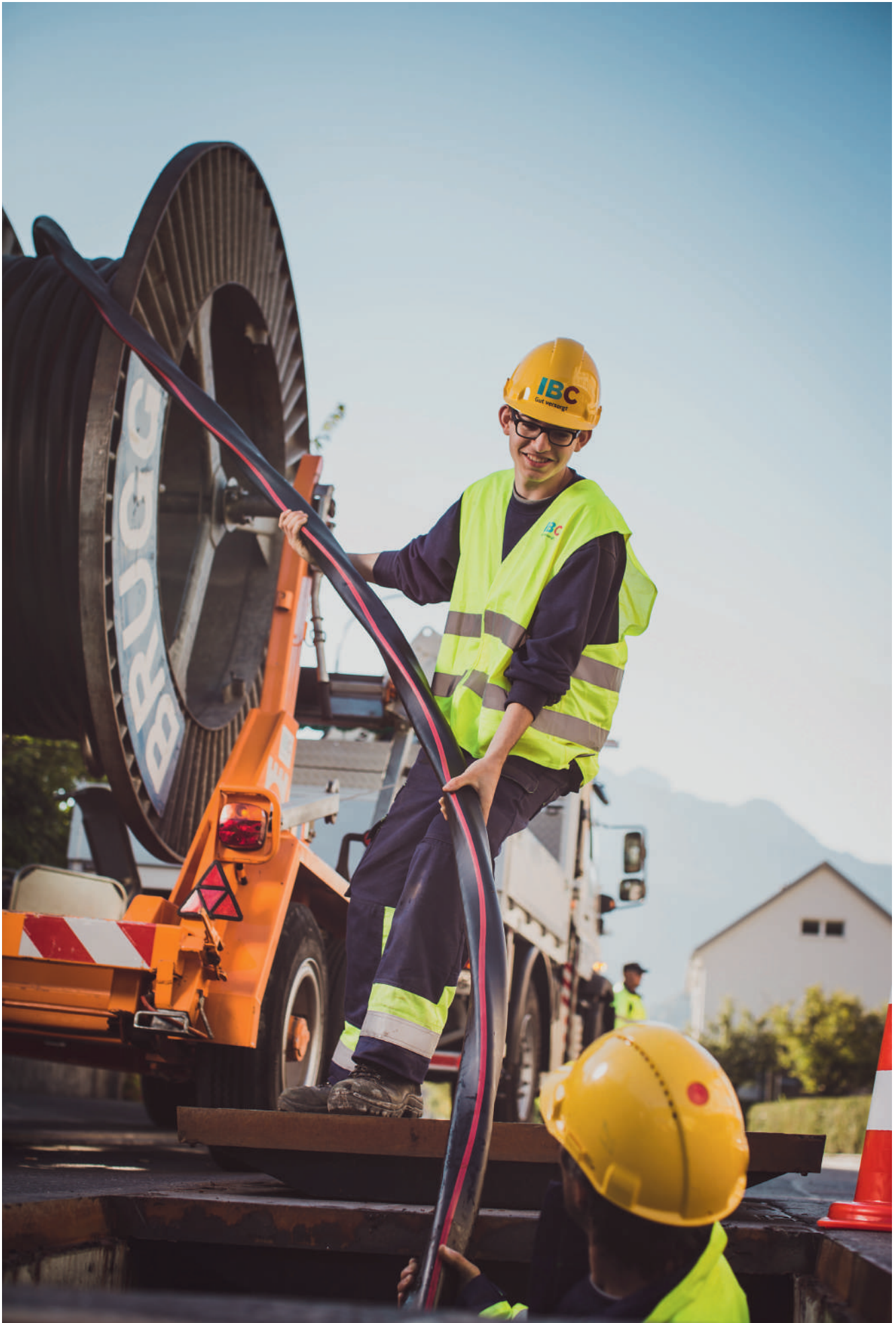
Kabelzug 10-Kilovolt-Leitung, Scalettastrasse
