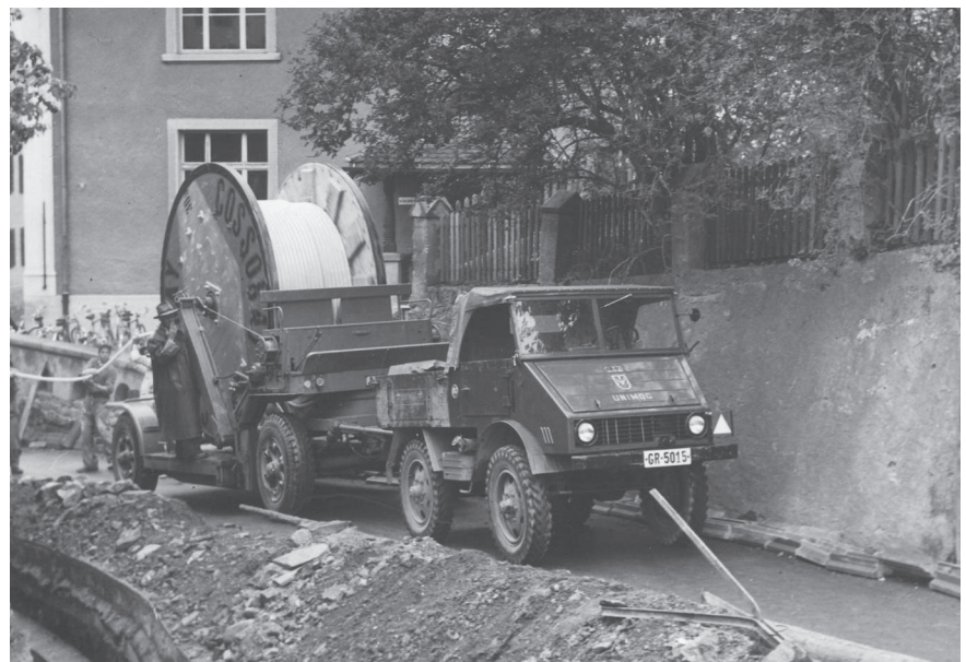
Um 1955: Kabeleinzug öffentliche Beleuchtung entlang Plessurquai
