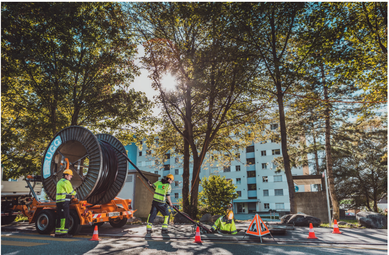
Kabelzug 10-Kilovolt-Leitung, Saluferstrasse
