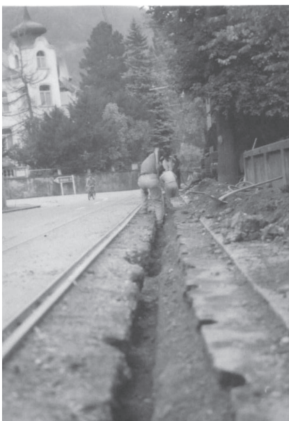
Um 1955: Kabeleinzug öffentliche Beleuchtung entlang Plessurquai
