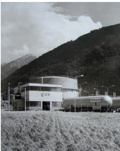
1970: Betriebsgebäude an der Industriestrasse, Gasometer mit 5'000 m<sup>3</sup> Fassungsvermögen (Durchmesser 26,2 m)
