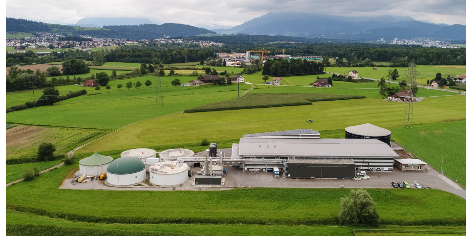
Biogasanlage in Inwil © Alessandro Della Bella
